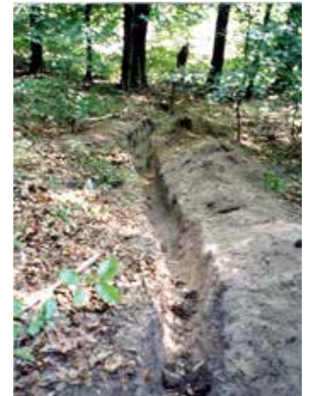
Graben für die Sammelleitung im Quellenbereich (2009).
