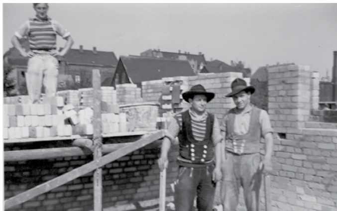
Siegfried Hesse (links) mit einem Kollegen auf einer Baustelle in Lüdenscheid Ende der 1950er Jahre.
