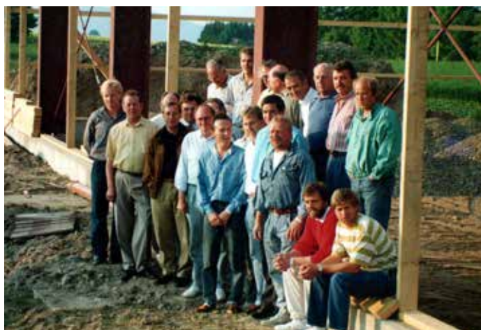
Bau der Tennishalle 1990.
